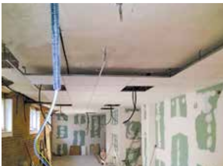
Baustelle im Klublokal
